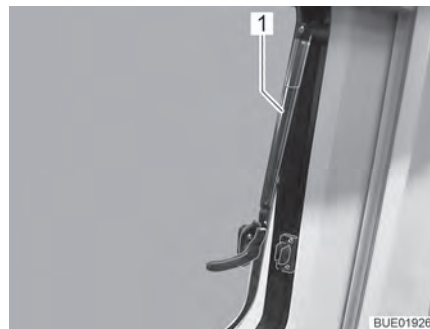
Bild 19 Överkantshängt fönster med automatik-spärrar, öppet
